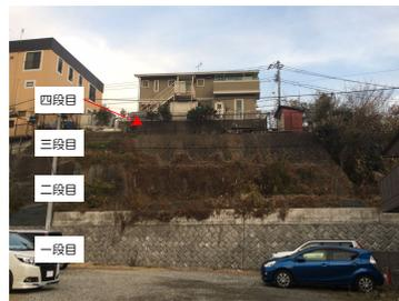
上下のひな壇上に配置され、その擁壁が互いに近接して設置されているもの。上段の擁壁の荷重が下段の擁壁に作用するため、下段の擁壁は不安定な状況となりやすい。
