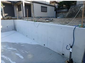
鉄筋コンクリート造で、水平荷重に対しては片持ちばりとして抵抗し、底版上の土の重量を安定に利用できる擁壁。
