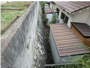
既存擁壁の上にコンクリートブロック（CB）を積み上げた状態のもの。コンクリートブロック（CB）は土圧に対しては抵抗できない。
