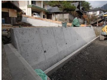
擁壁自体の重量により土圧に抵抗する擁壁。基礎地盤が良好である場合に使用される。
